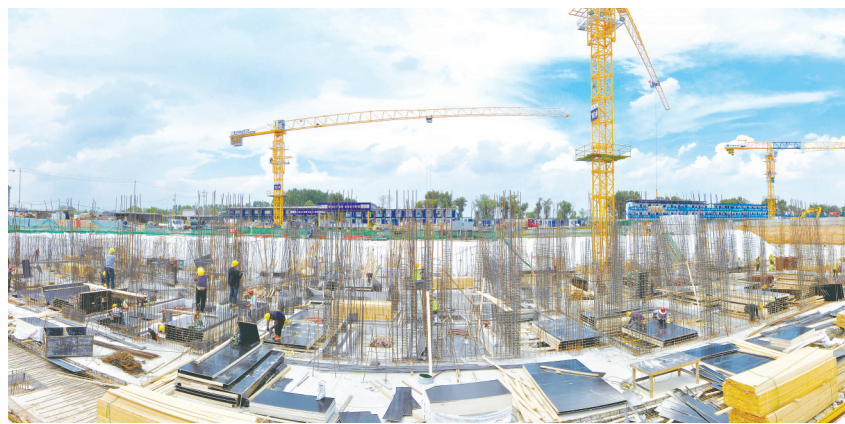
配套住宅项目现场,施工人员正在有条不紊地进行作业
